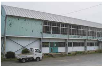
久賀小学校耐震・大規模改造工事
