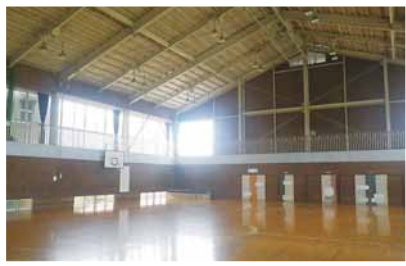
高井小学校体育館改修工事
