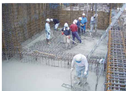
根切り工事を終え、コンクリート注入
